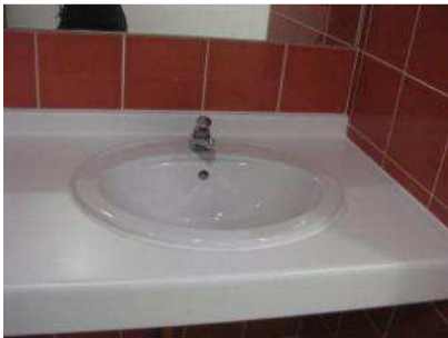
Lavabo sur plan de travail Robinet type presto à fermeture temporisée
