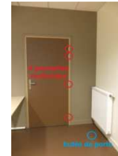
4 paumelles renforcées Butée de porte
