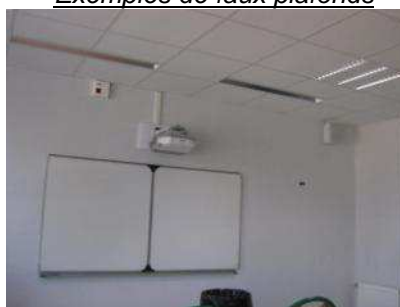
Faux plafond démontable
