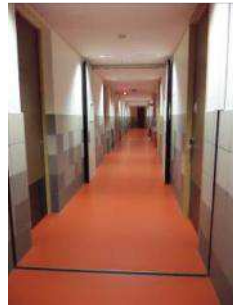
Protection en carrelage
