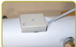
Sonde prévue pour un montage en applique, calorifuge reposé
