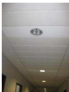
Faux plafond démontable
