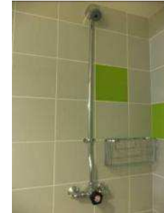
Exemple de mitigeur à fermeture automatique
