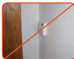
La sonde est dans un coin de la pièce et partiellement masquée par un meuble
