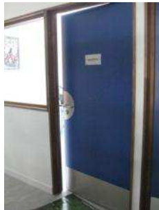
Porte avec plaque de propreté et plinthe « coup de pied »
