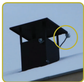
La sonde est dans le plan des capteurs solaires, sans masque
