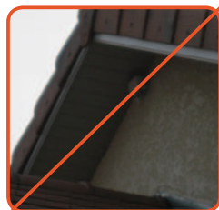
La sonde est dans un renfoncement où la température est différente ; le rayonnement solaire est réfléchi par la toiture en-dessous
