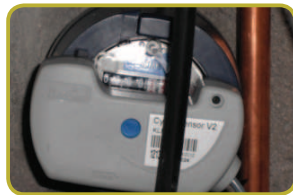
Compteur d'eau avec et sans émetteur d'impulsions (placé sur l'aiguille)
